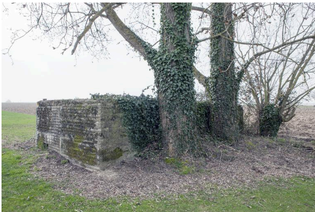
Vue de trois-quart arrière, vers le sud
