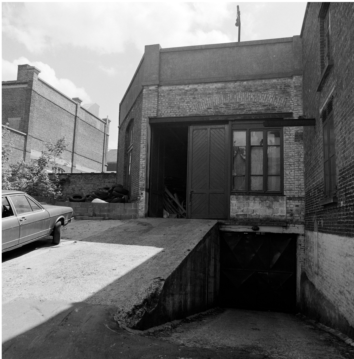
Rampe d'accès au sous-sol.
