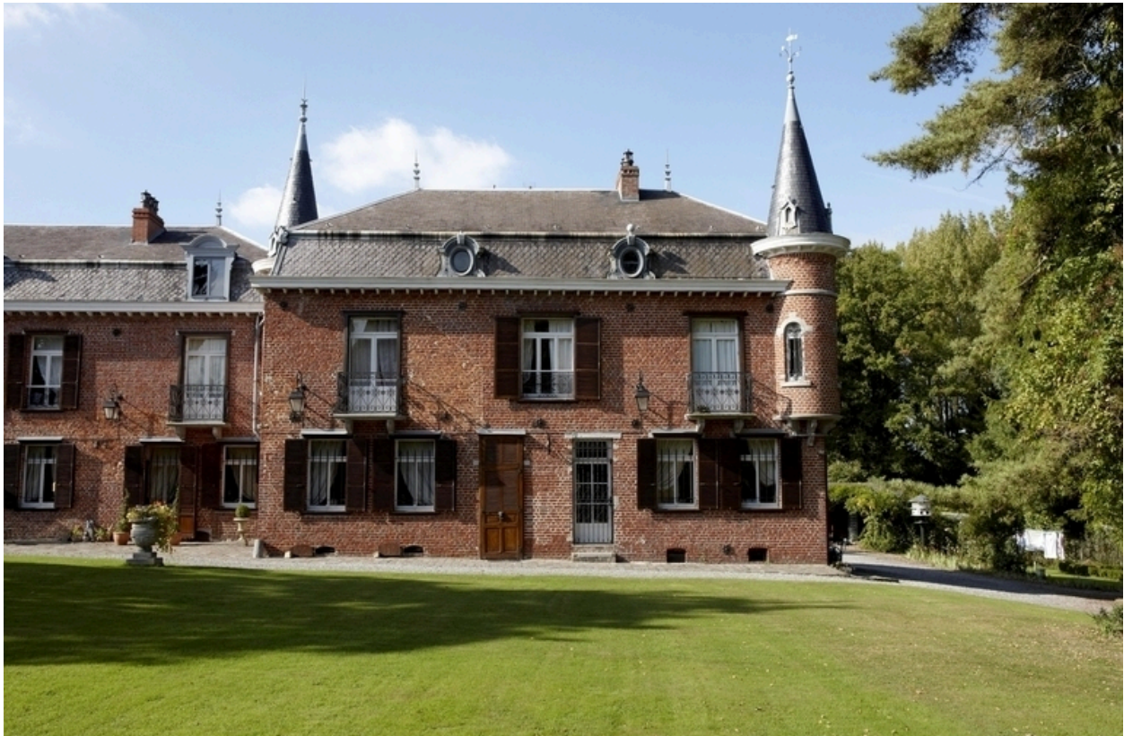
Vue du second bâtiment, rajouté dans les années 1890.
