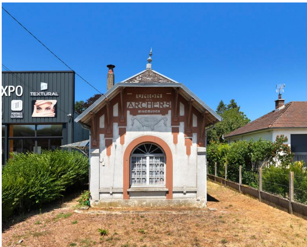
Vue de la façade sud du logis.
