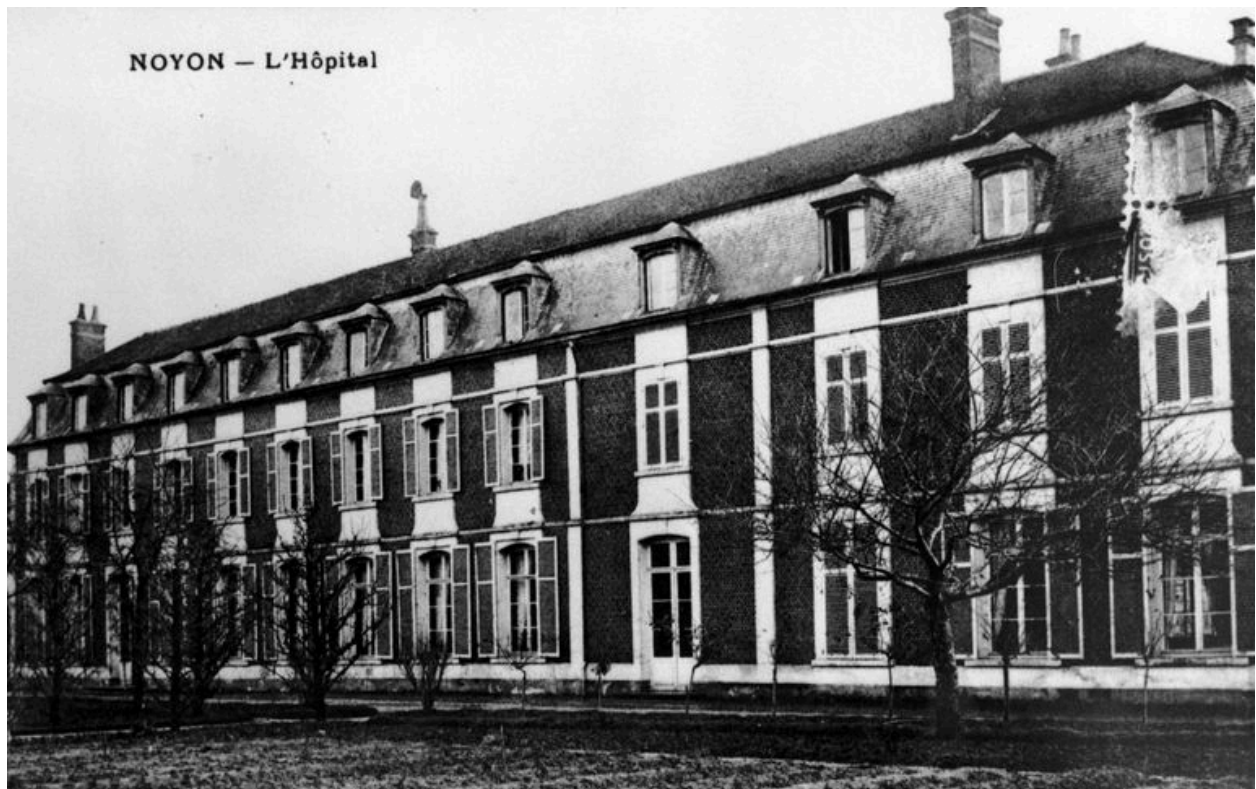
Bâtiment du 19e siècle, avant 1914 (AP).
