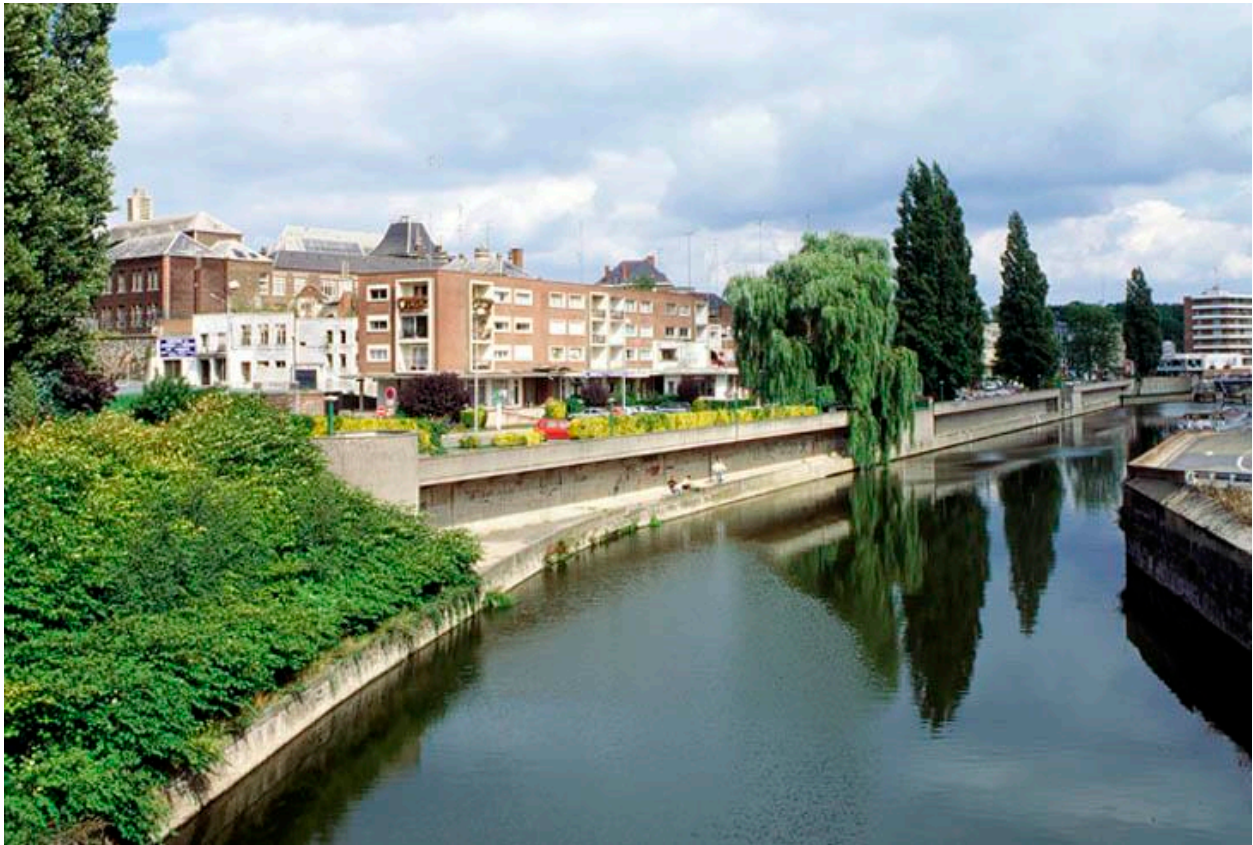
Vue générale du mail de la Sambre construit par André Lurçat, prise depuis le pont à l'ouest.
