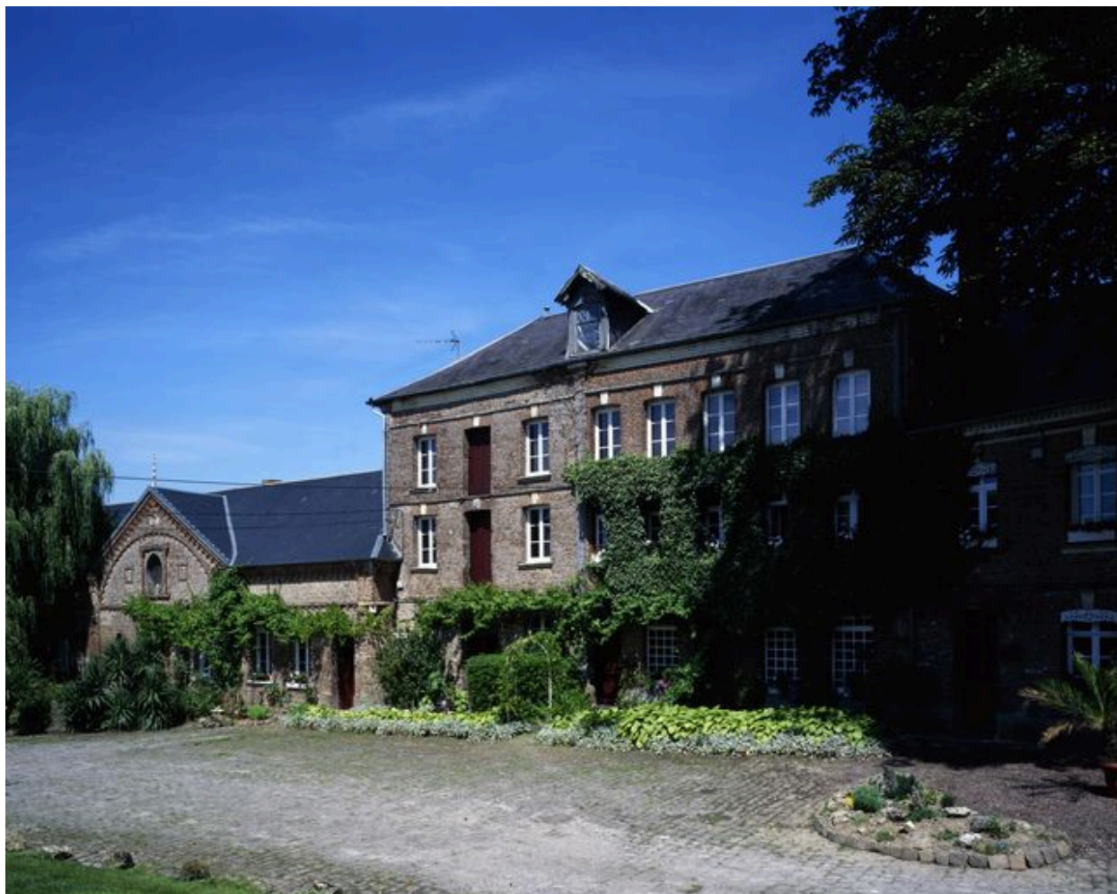
Logis et bâtiment d'exploitation.
