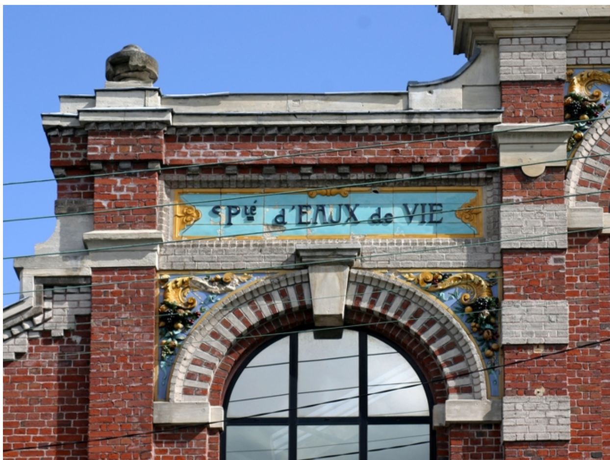
Façade antérieure, détail.
