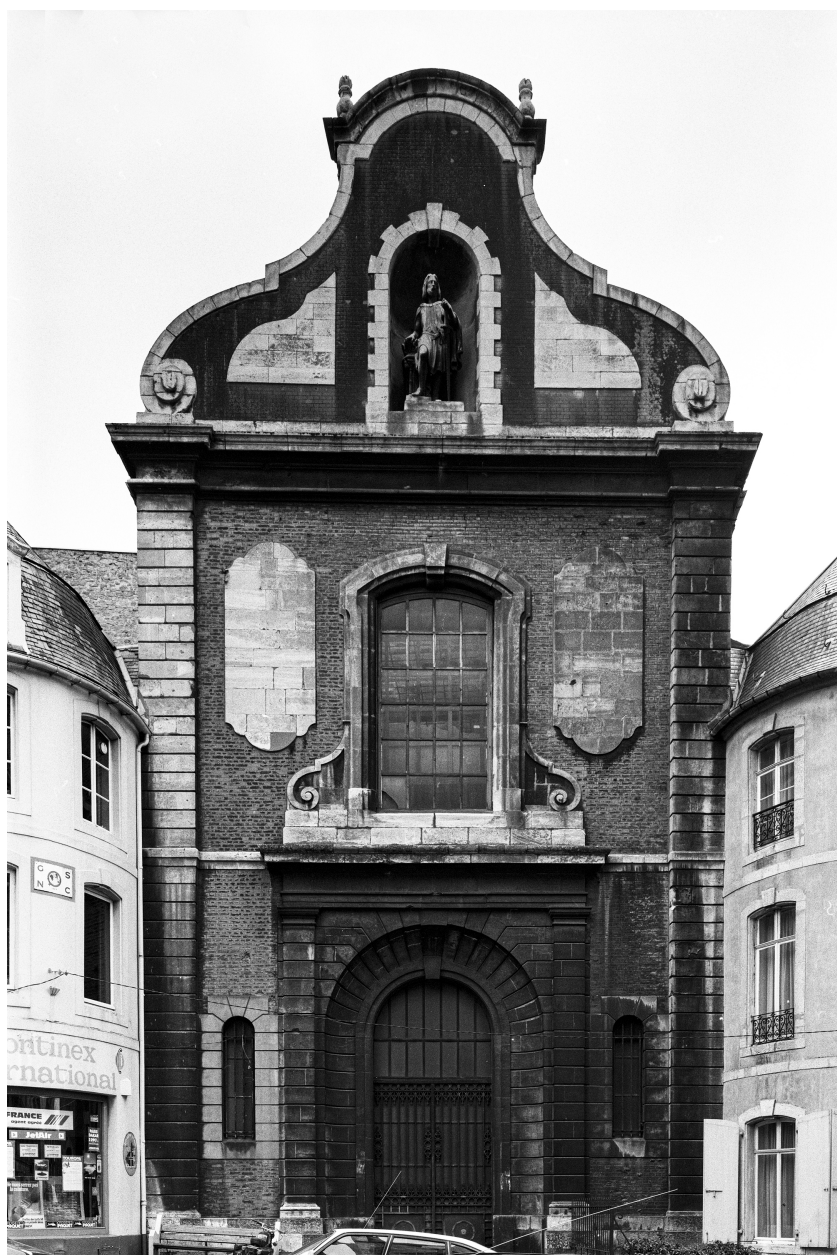
Chapelle, façade sur voie.
