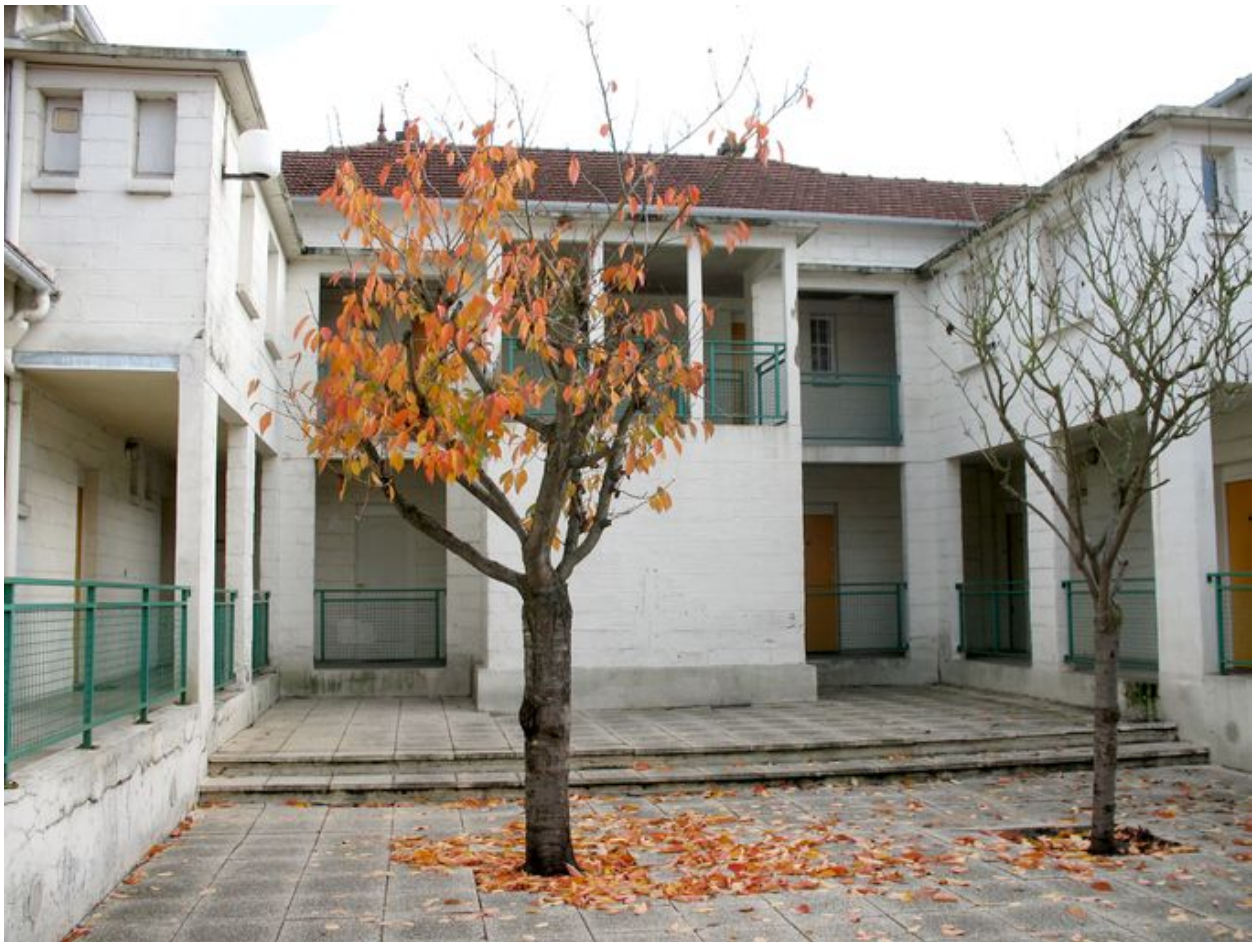
Bâtiment 523 : Cour intérieure.
