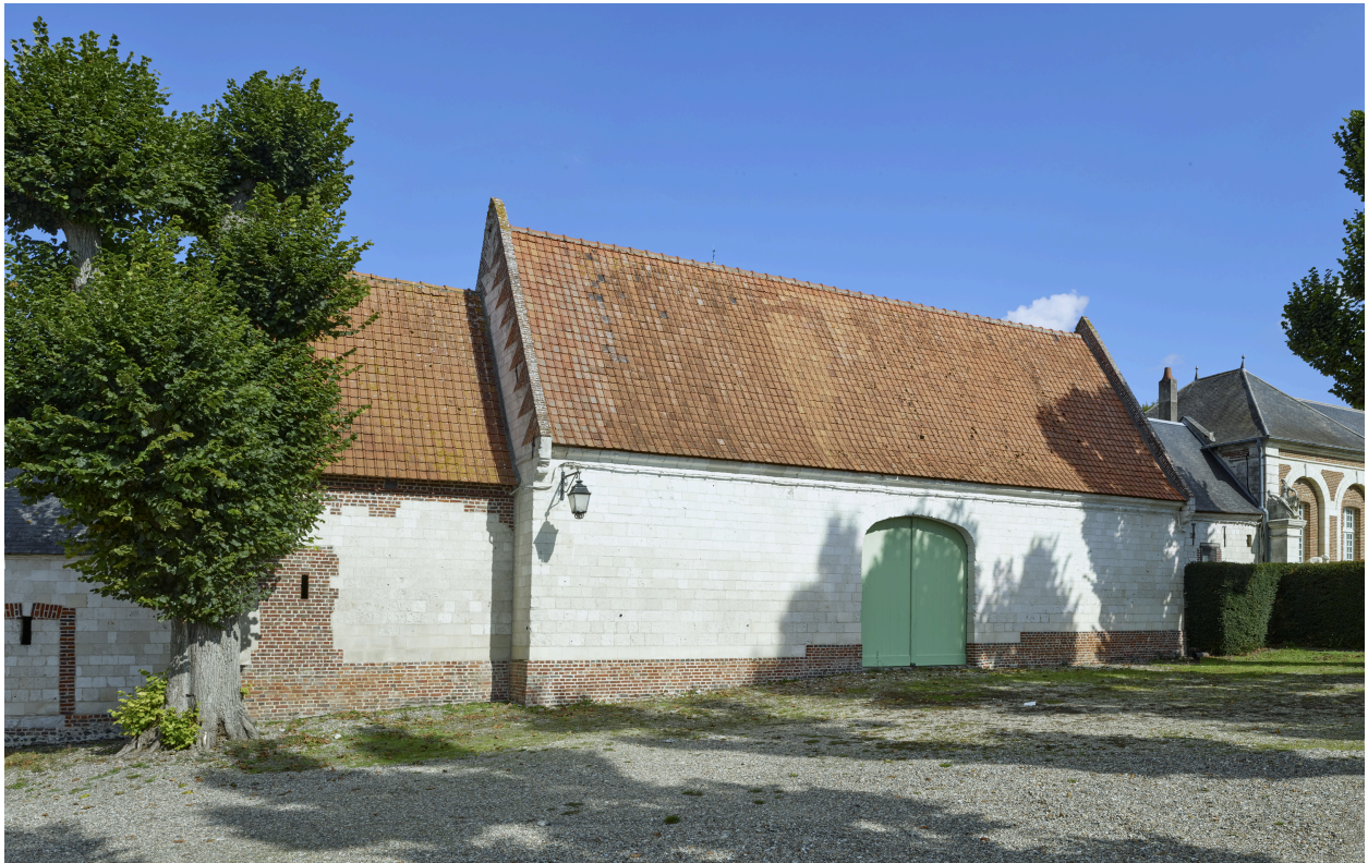
Bâtiment de la ferme du château, depuis la rue du château.
