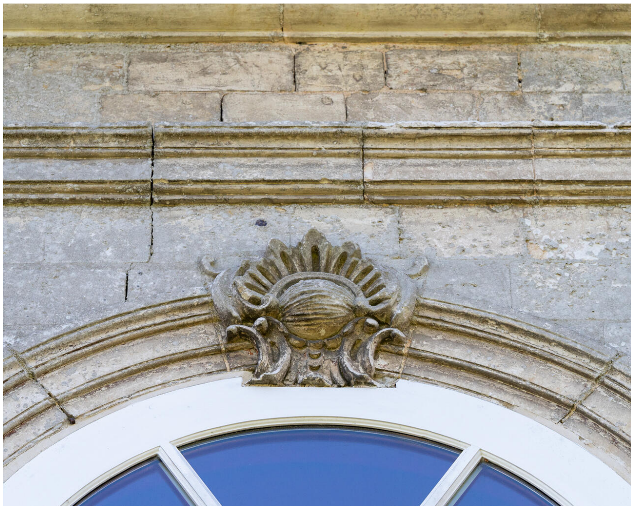
Façade nord donnant sur le jardin d'agrément. Détail de l'agrafe, de style rocaille, de la baie d'axe du second niveau.
