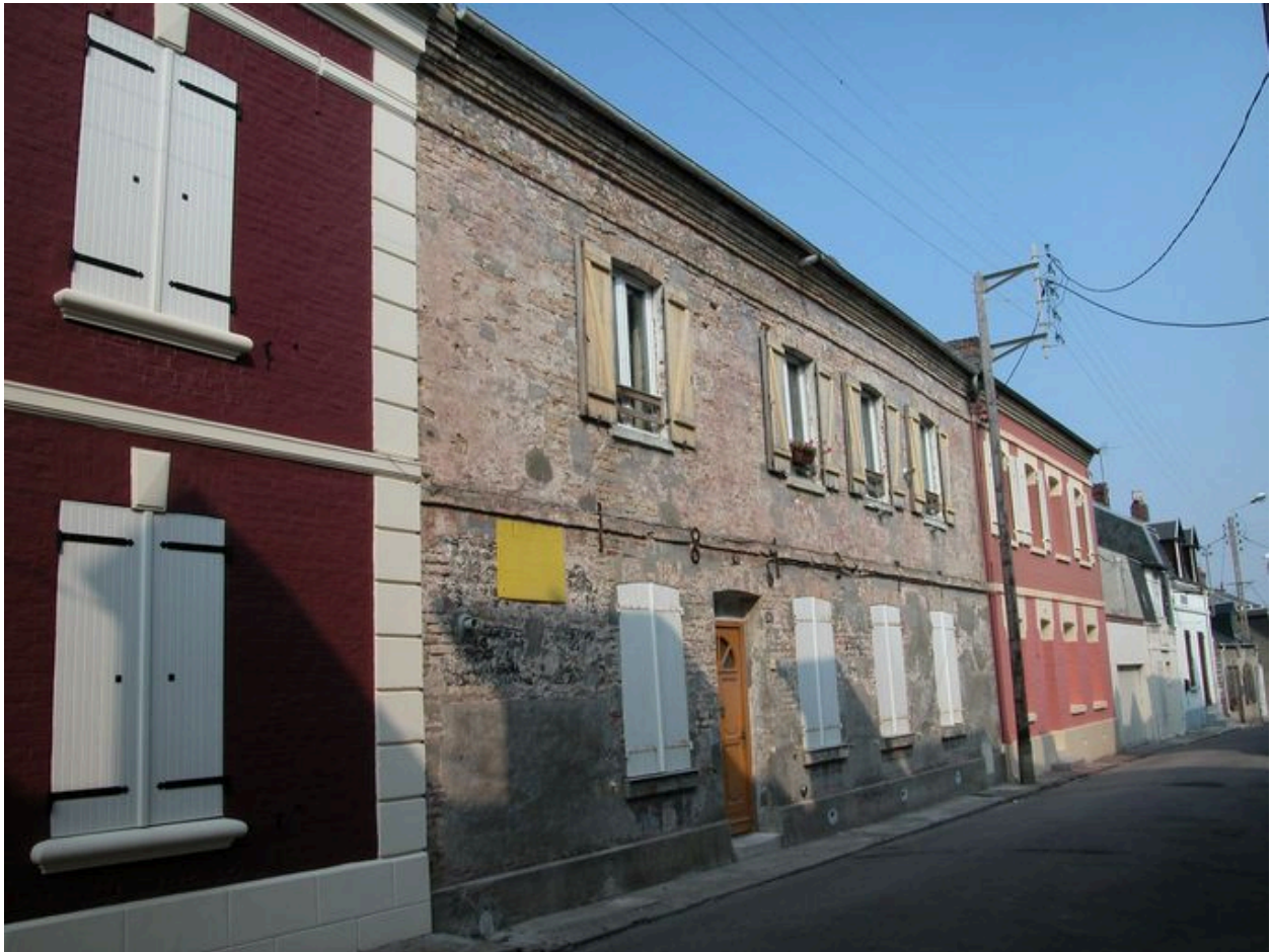
Maison, 11 rue Boyard (1988 BE 278), porte la date 1842.
