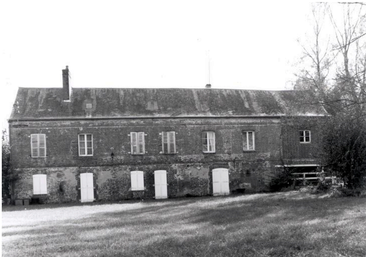
Vue d'ensemble sud-ouest du moulin.
