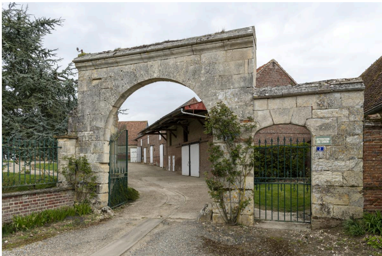
Portail en pierre, n°2 rue de Hénu, vue depuis l'ouest.
