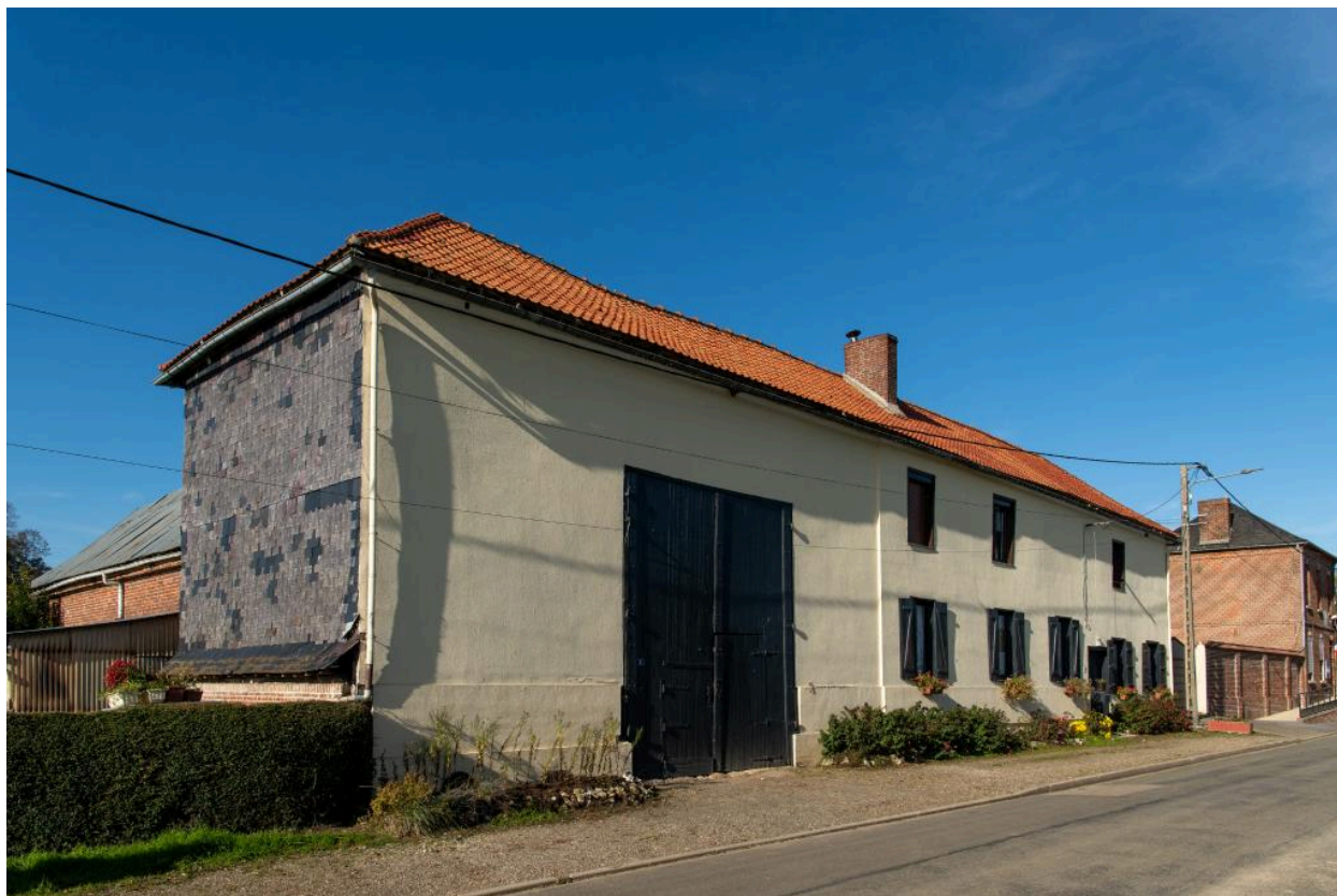
Ancienne fabrique de serges, n°8 rue Léger, vue depuis le sud-est.
