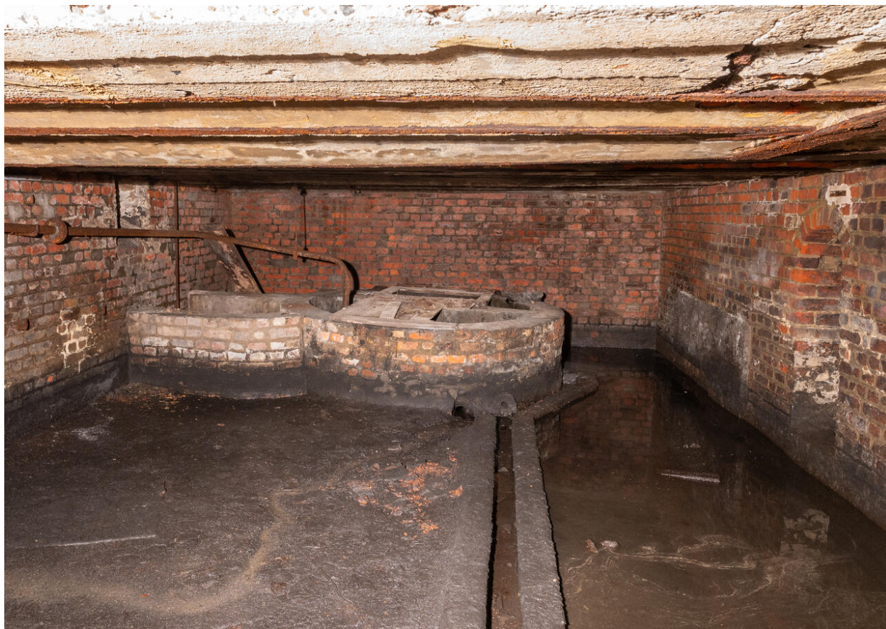
Vue des bassins-réservoirs situés en sous-sol de la filature.
