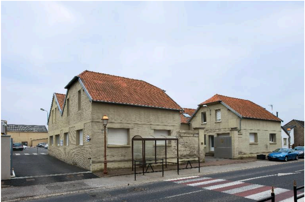
Entrée principale, 45 rue Jean-Jaurès.
