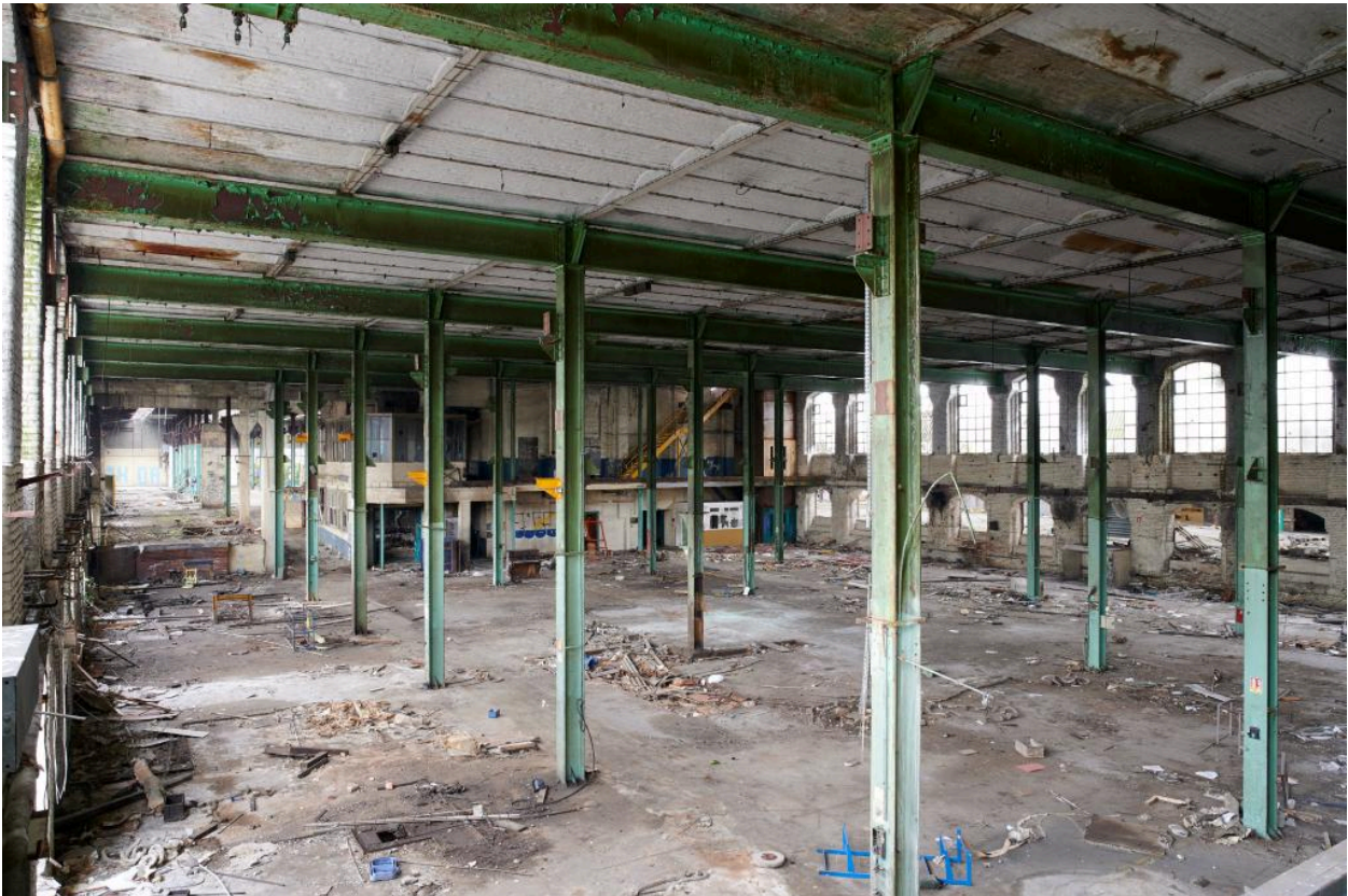
Vue intérieure de la filature (le plancher du rez-de-chaussée surélevé a été supprimé).
