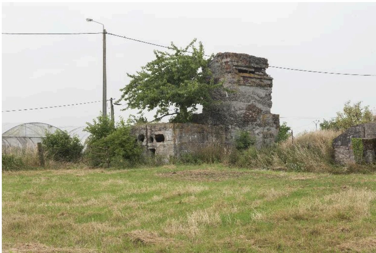
Tour d'observation casematée a, vers le sud-ouest
