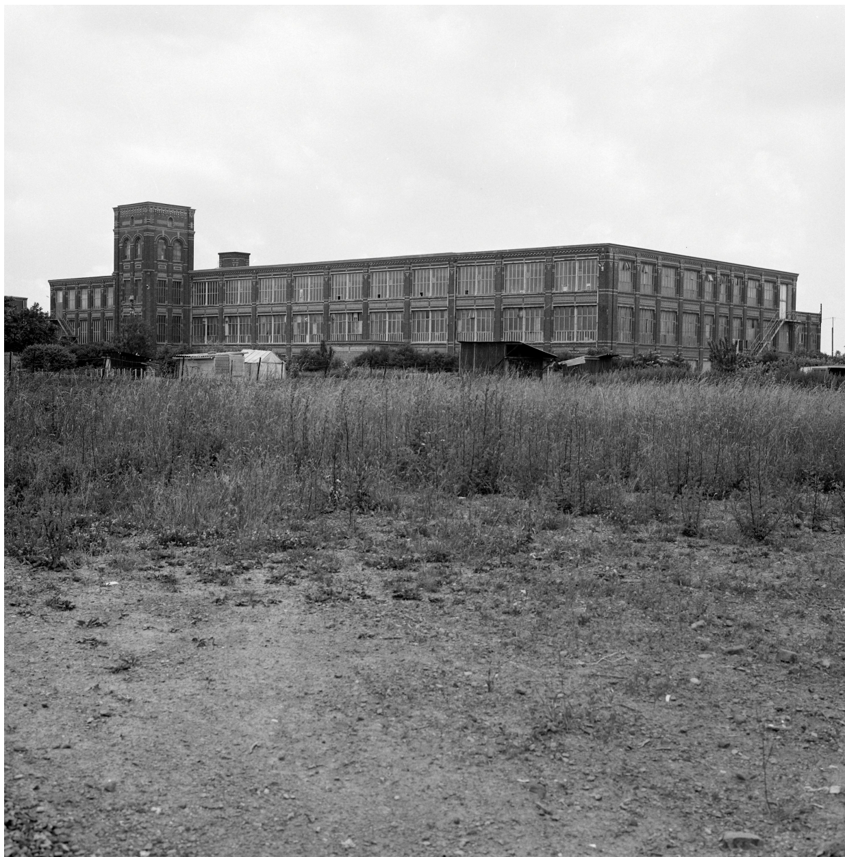
Vue générale prise depuis le sud.
