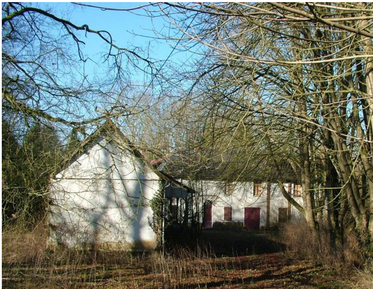
Vue générale des bâtiments de l'ancien moulin.
