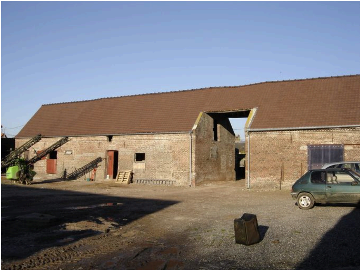
Vue du passage couvert et des bâtiments adjacents depuis la cour.
