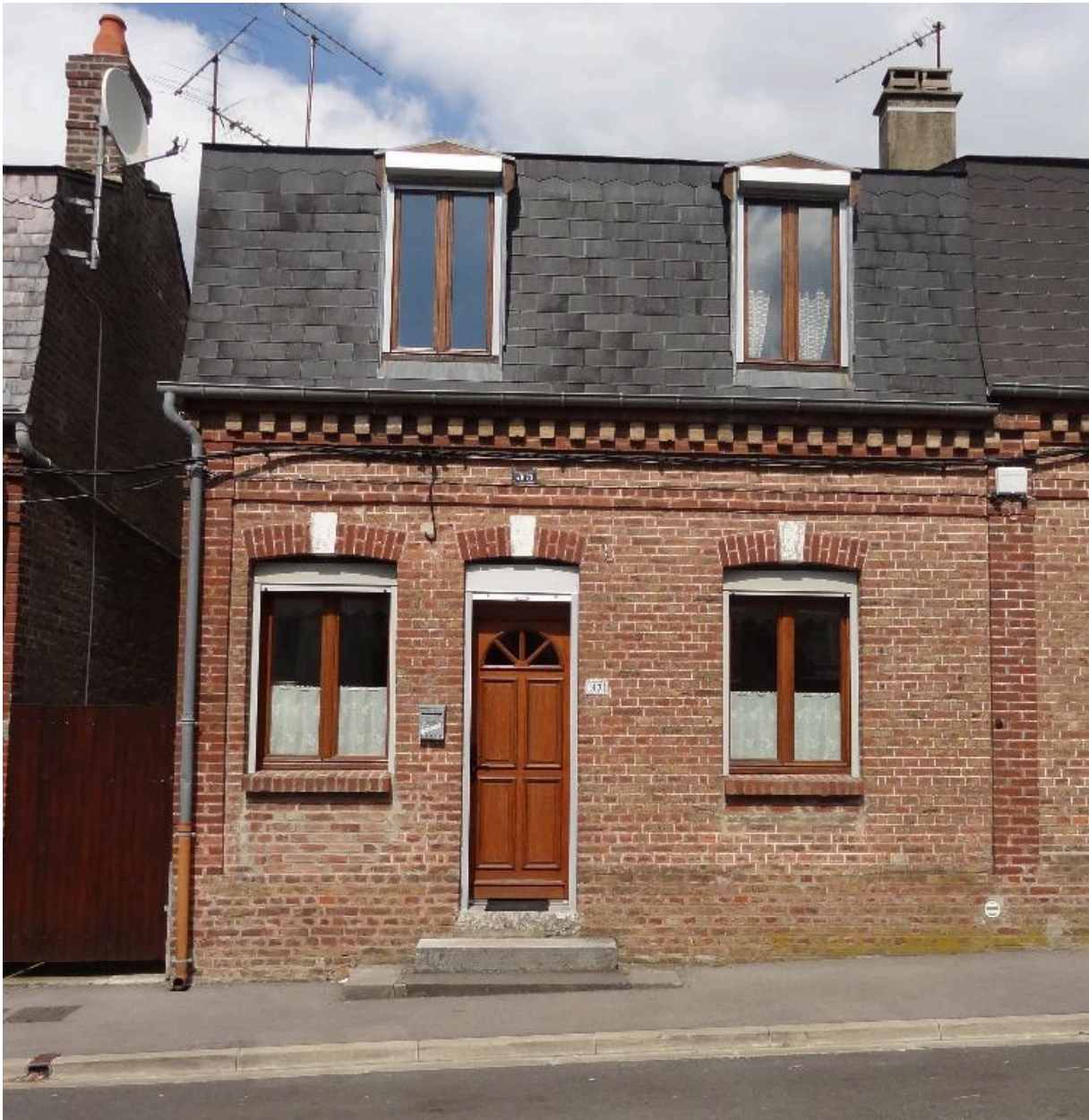
Vue du logement n°37 rue Jules-Vallès et de la ruelle séparant les deux blocs de logements.
