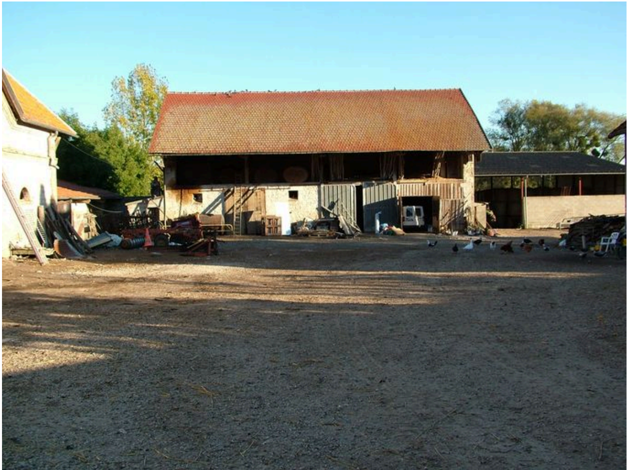
Vue de la grange située dans le fond de la cour.
