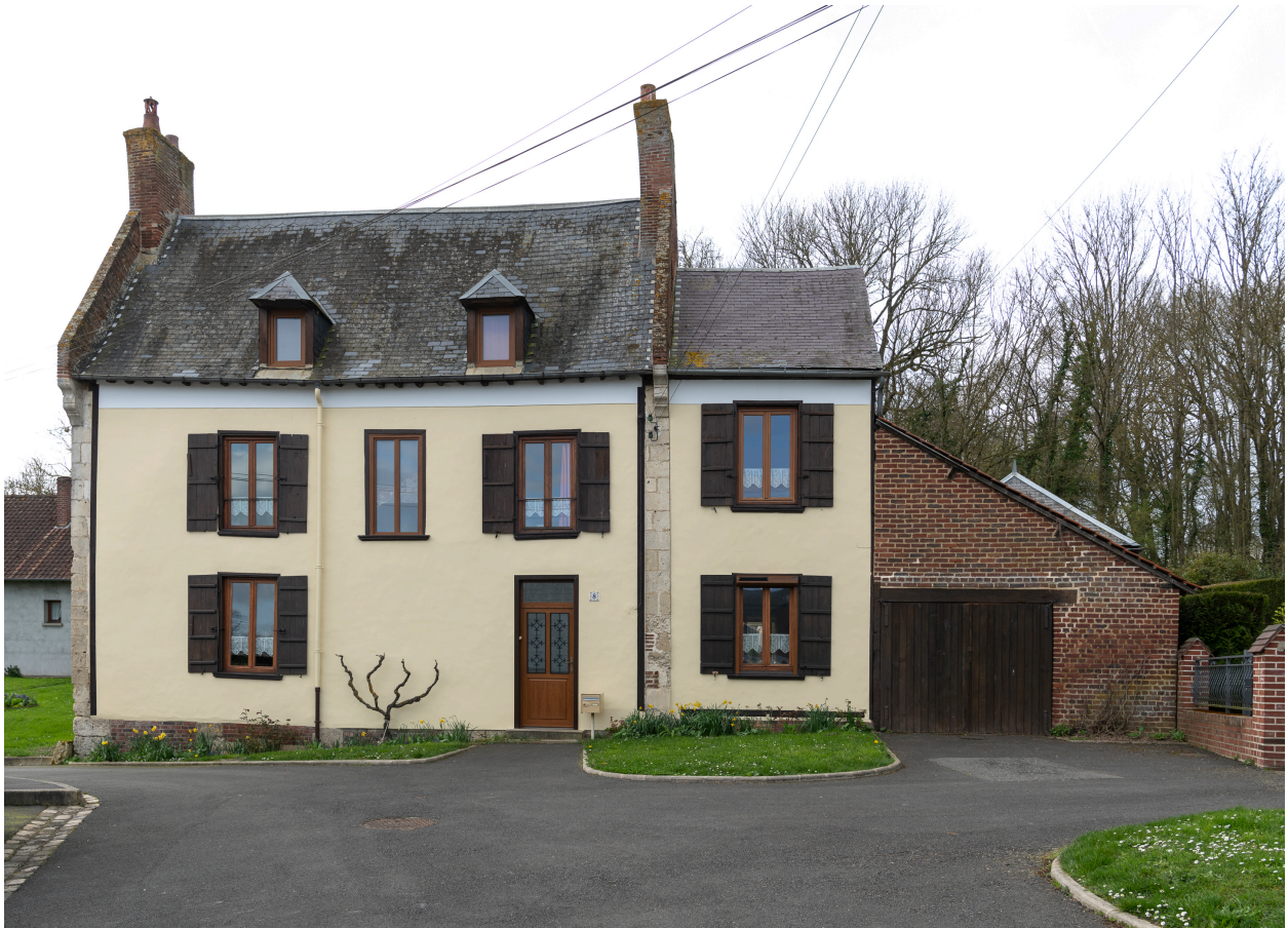
Ancien presbytère, n°8 de la rue aux Prêtres, vue depuis l'est.
