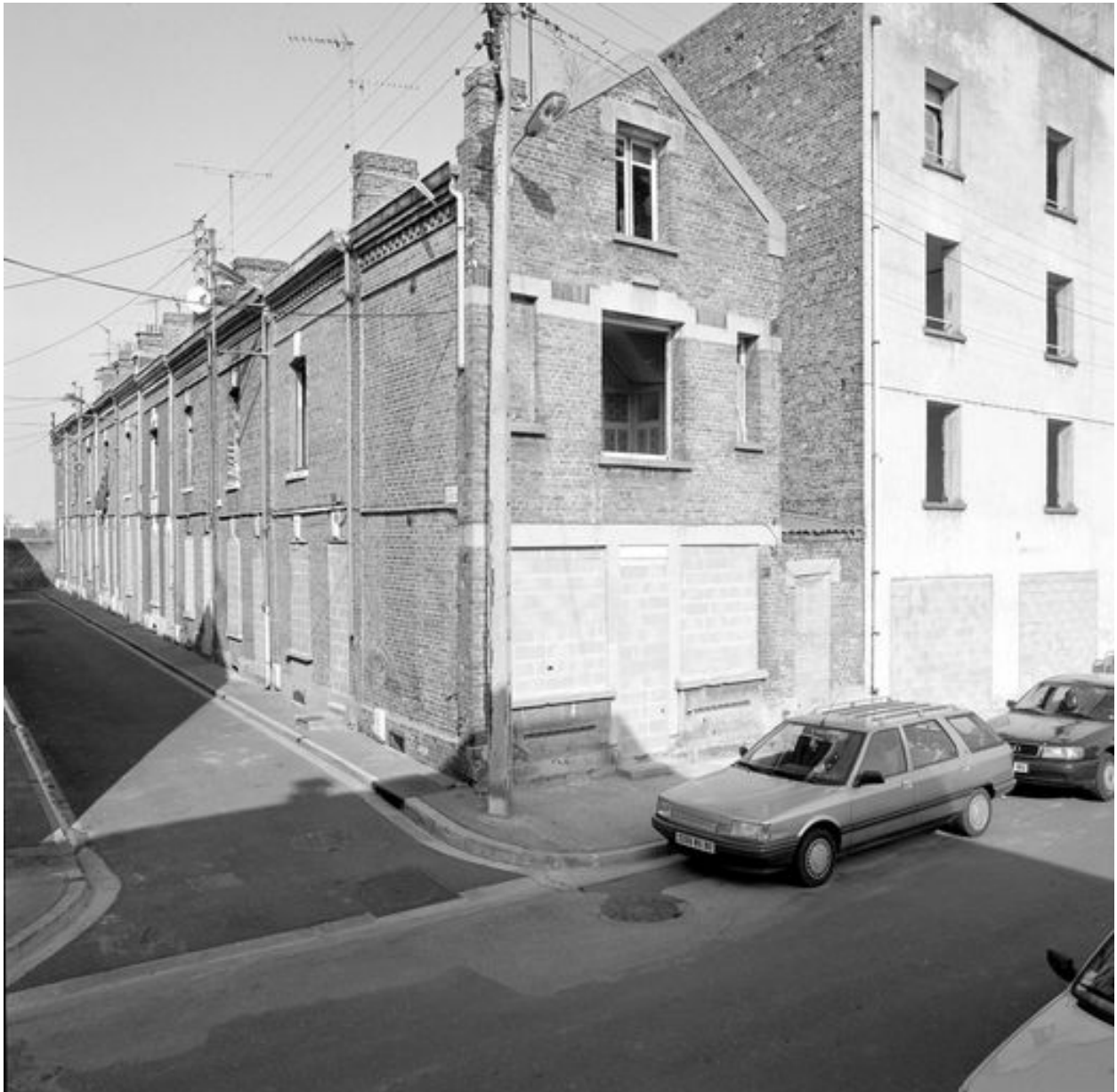
Vue de la rive est.
