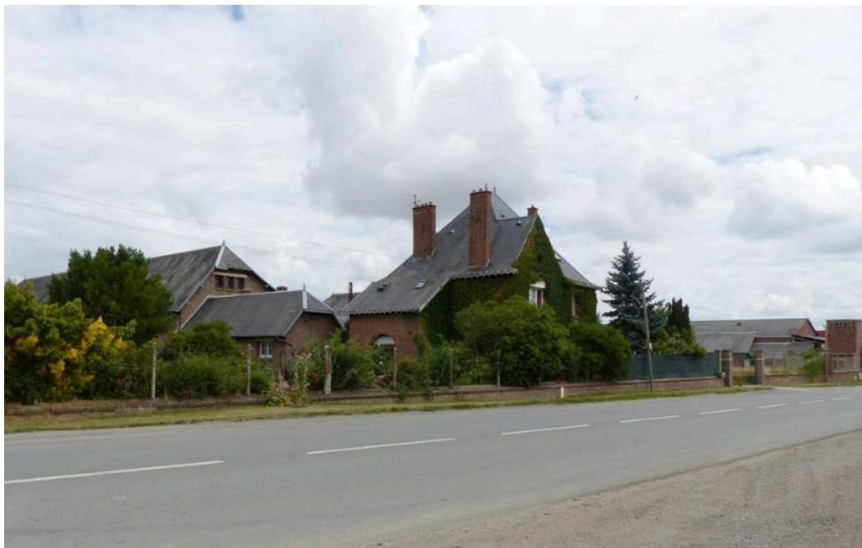
Vue de situation, depuis le sud-ouest.
