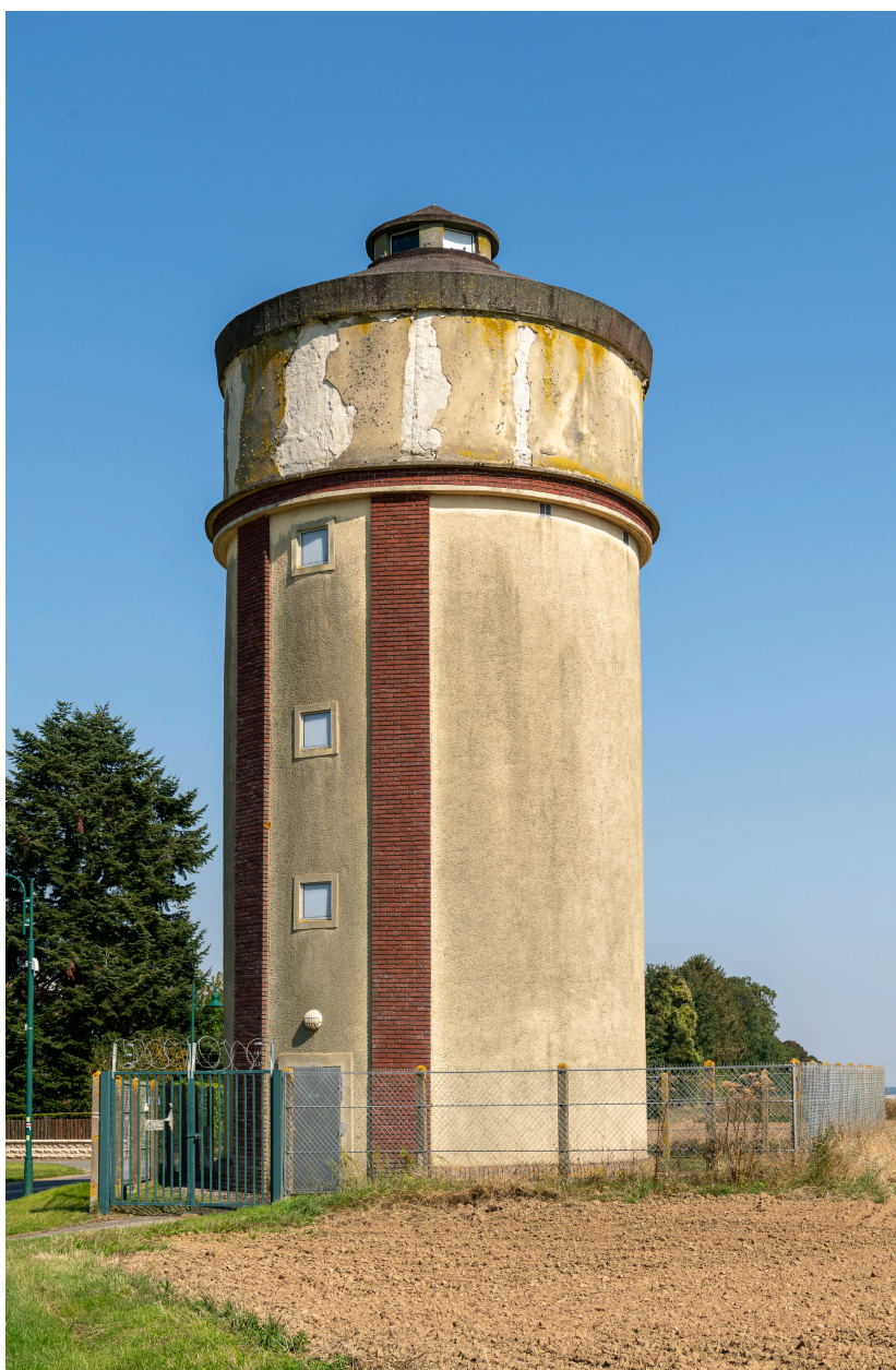
Château d'eau, sortie sud du village.
