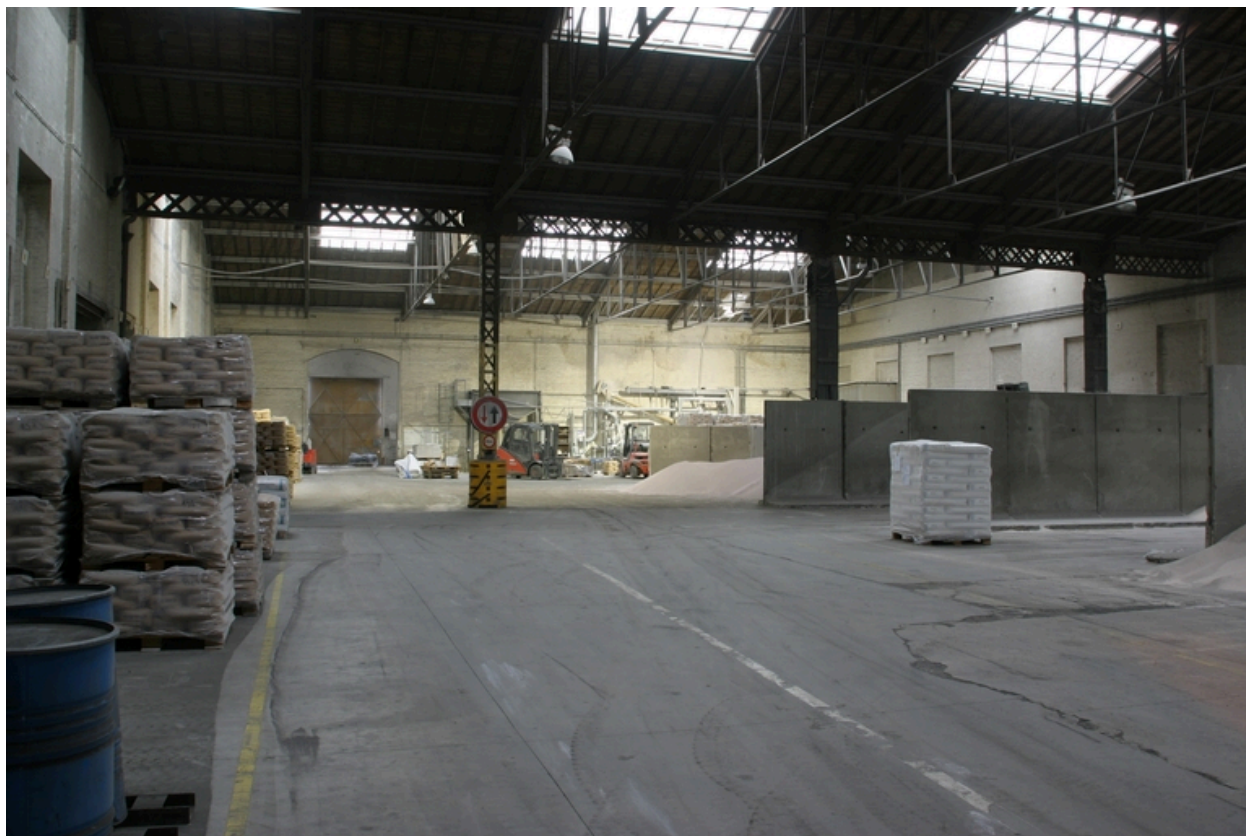
Vue intérieure des halles de 1908.
