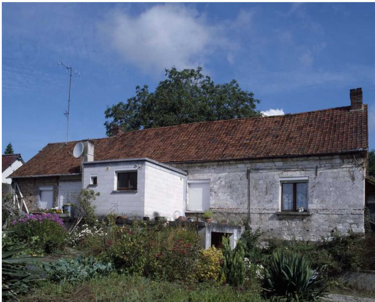
Vue postérieure du logis.
