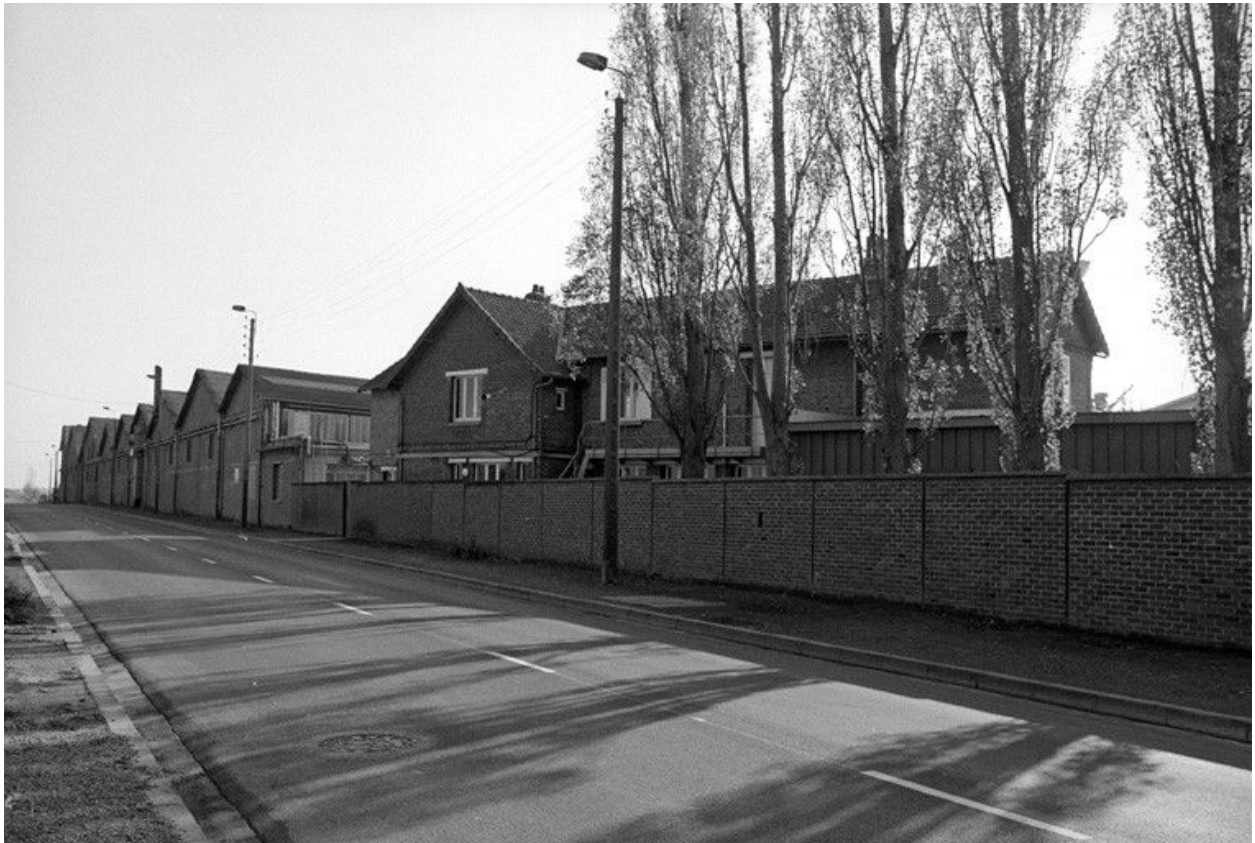
Atelier de fabrication, vue partielle, flanc nord ouest.
