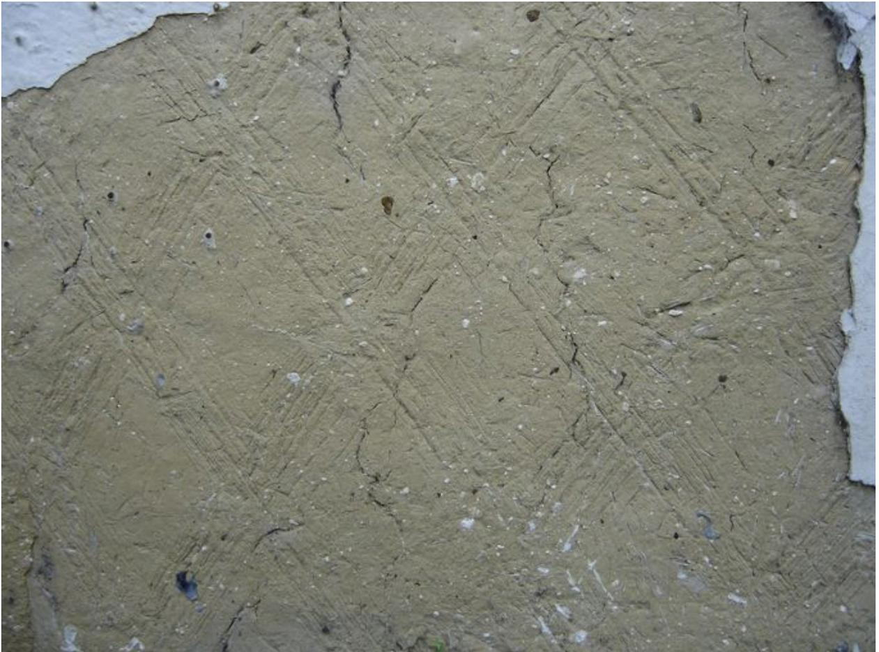
Détail du torchis et des sillons permettant une meilleure adhésion de l'enduit de finition.
