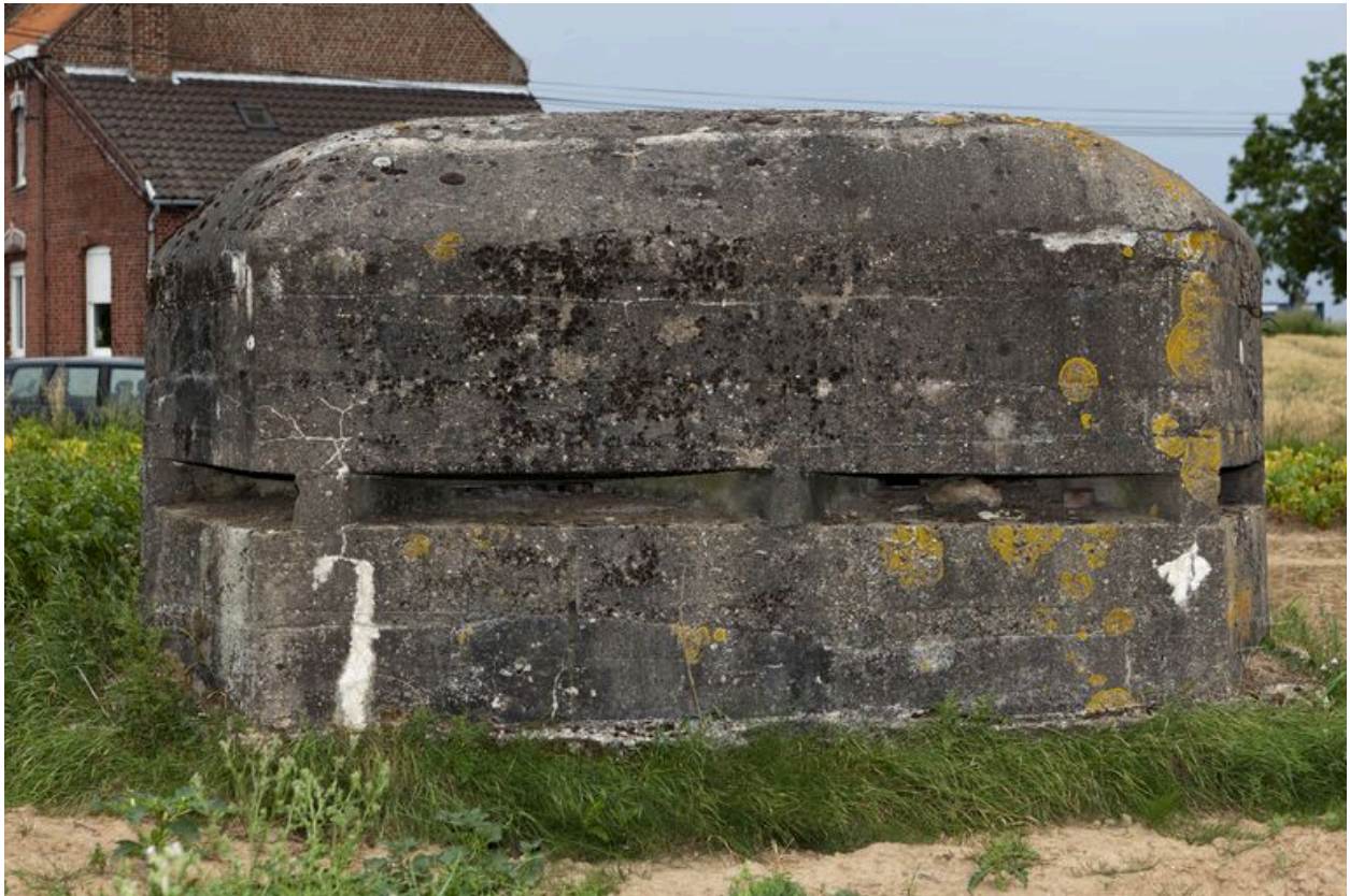
Vue frontale, vers le sud-est
