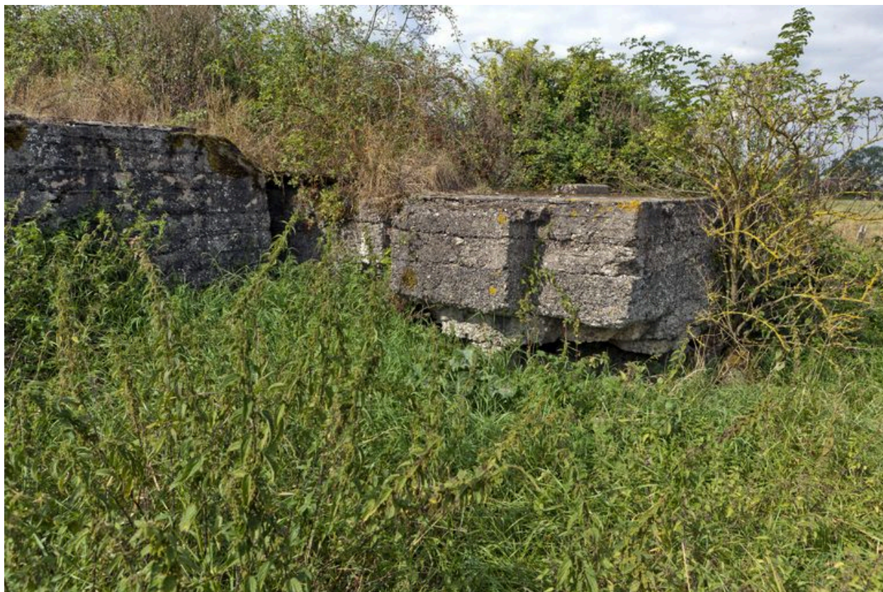
Casemate A : Extrémité nord-est
