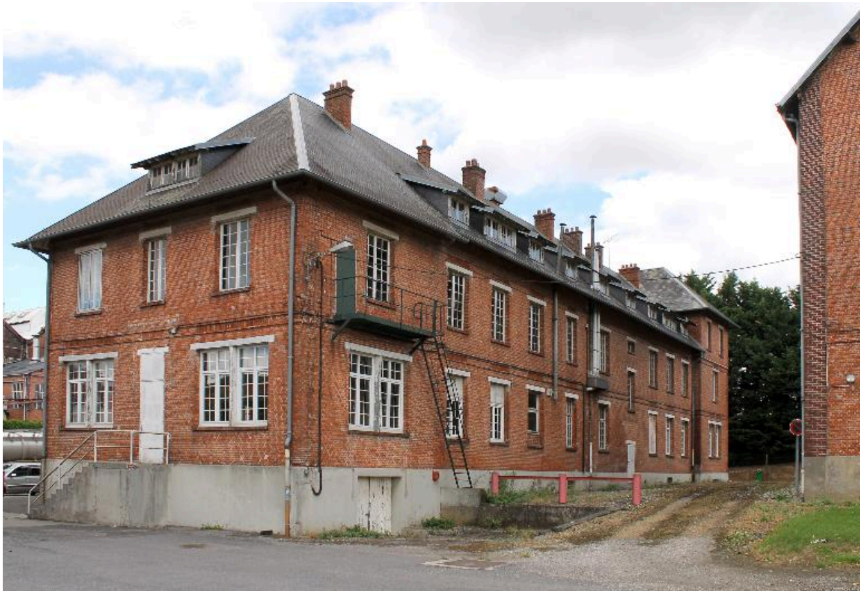
Vue de la façade postérieure, de trois-quarts.
