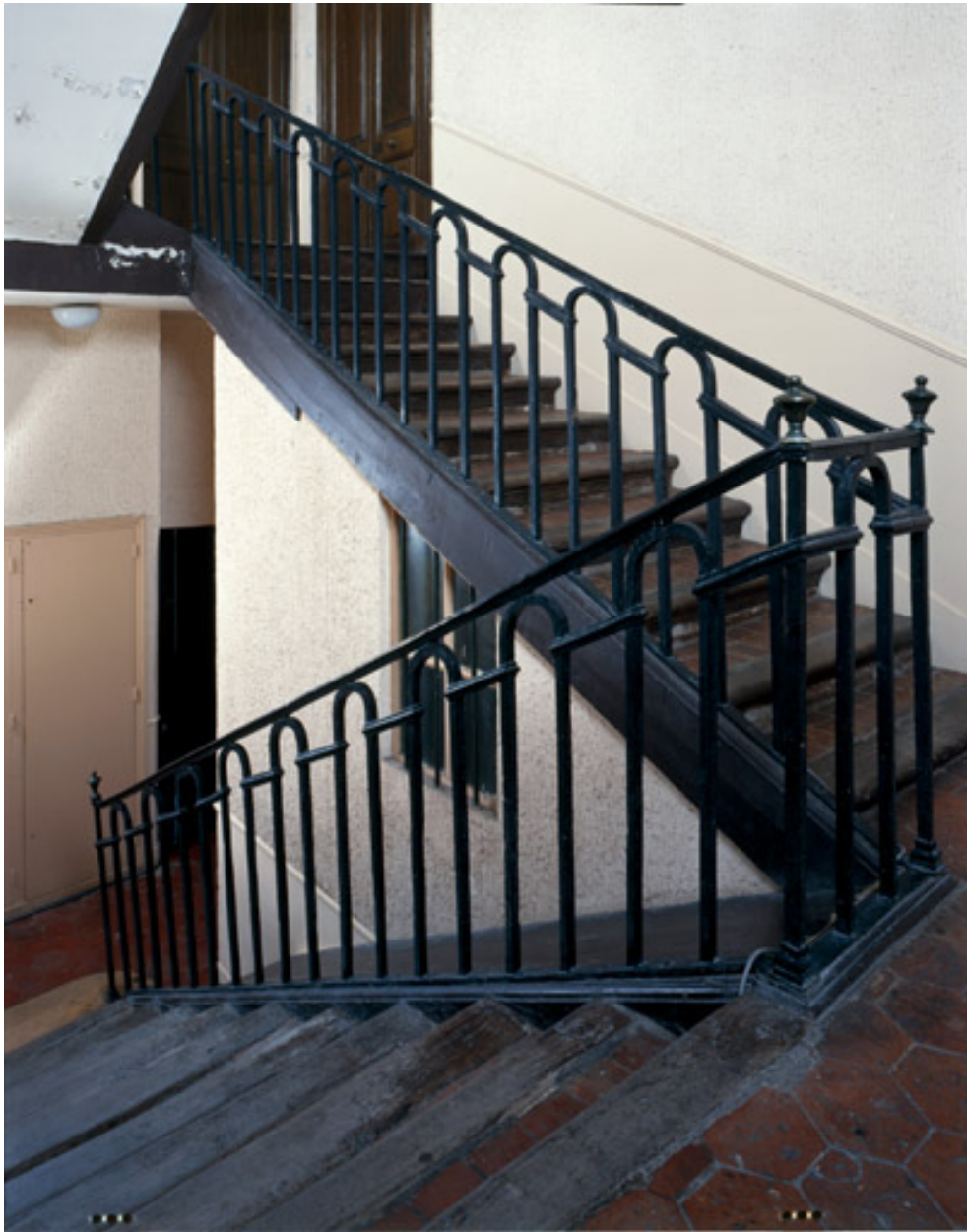
L'escalier du logis sur rue.
