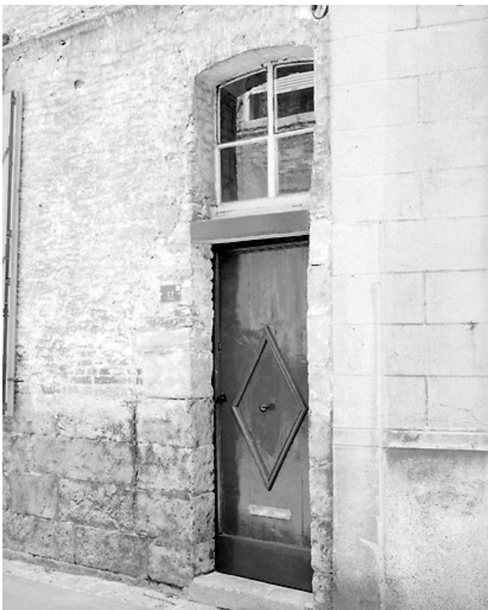
Façade, rez-de-chaussée, détail : porte avec fenêtre d'imposte et menuiserie du début du 19e siècle.
