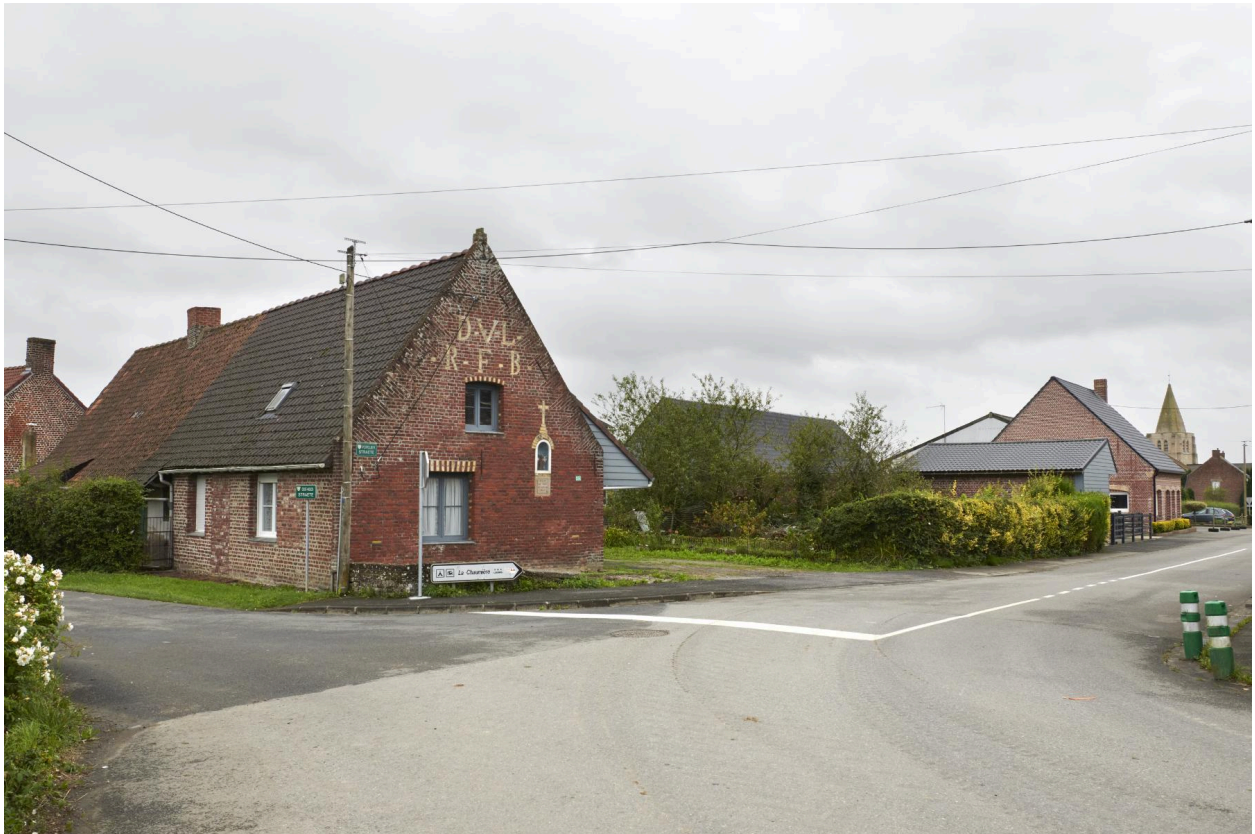
Façade nord et pignon ouest, depuis le carrefour.
