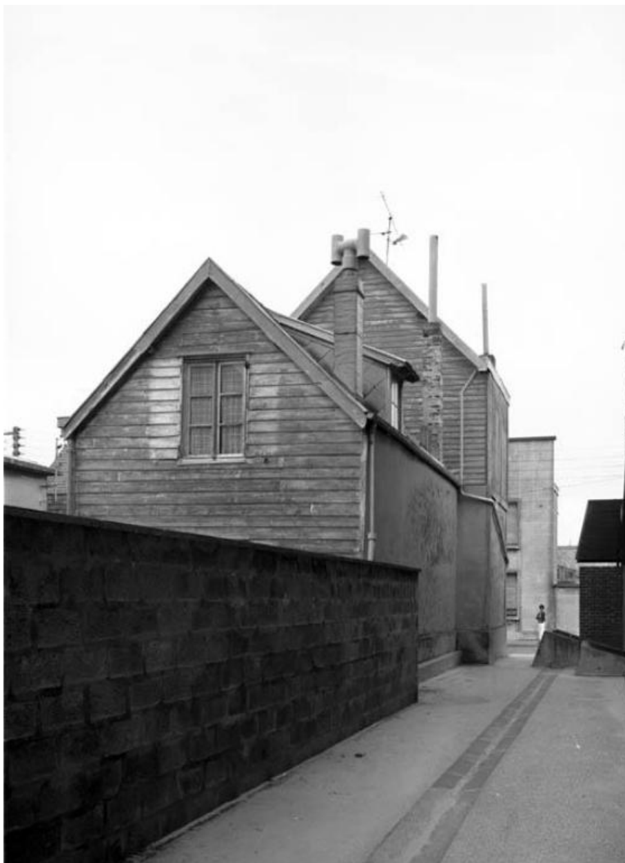
Façades postérieure et latérale gauche.
