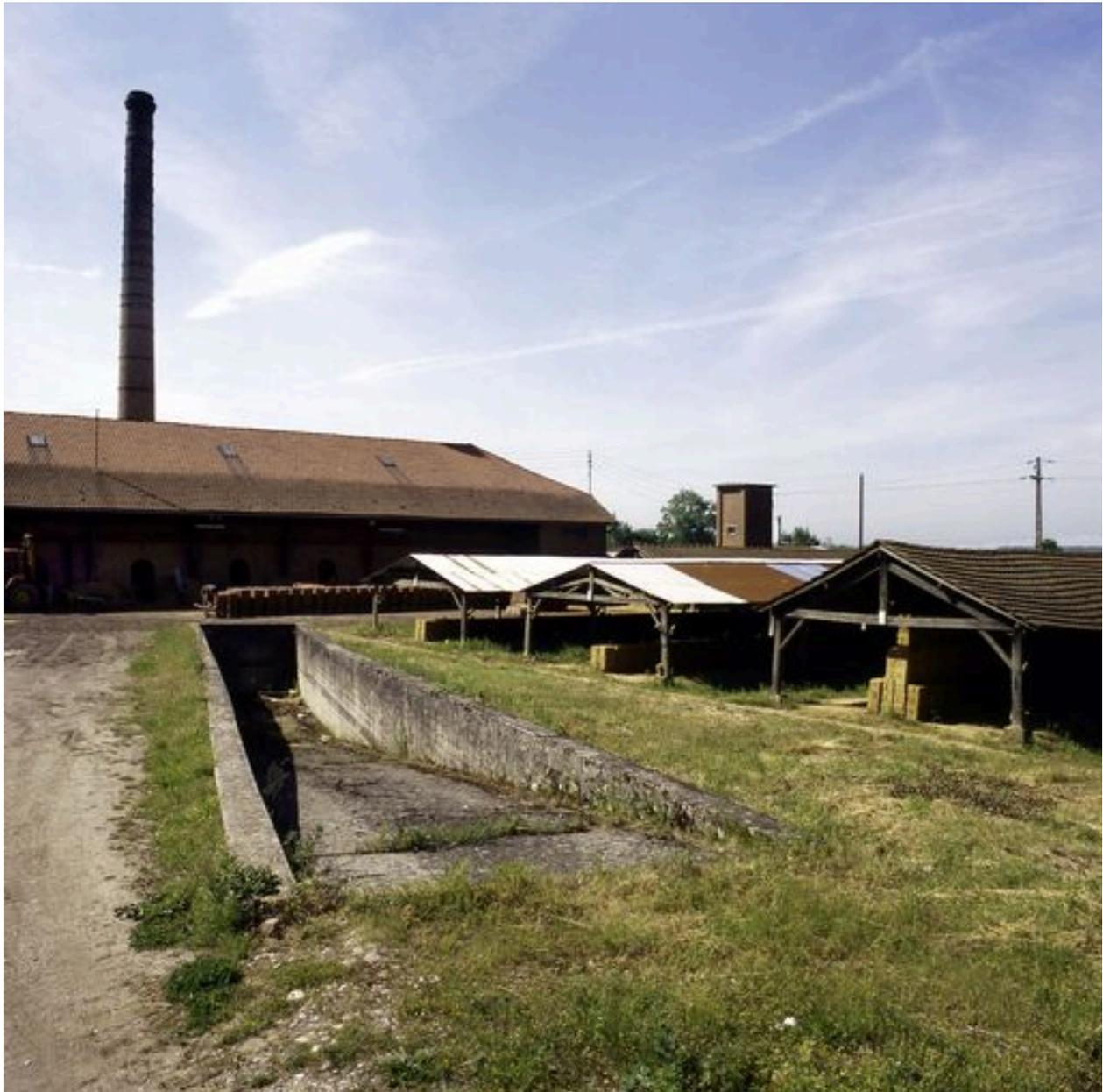
Vue des halles de séchage et d'une partie du four de cuisson. Au premier plan, la fosse de chargement.
