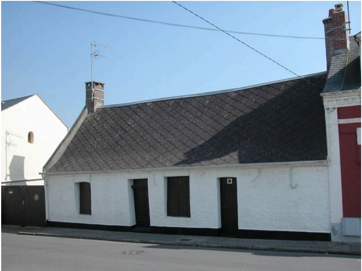
Une maison ancienne (58 rue Léon-Parmentier).
