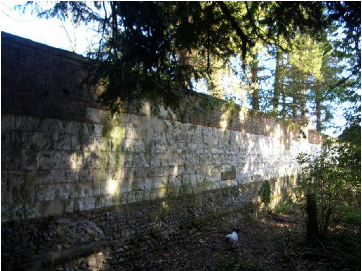
Vue du mur de clôture au nord de la propriété.
