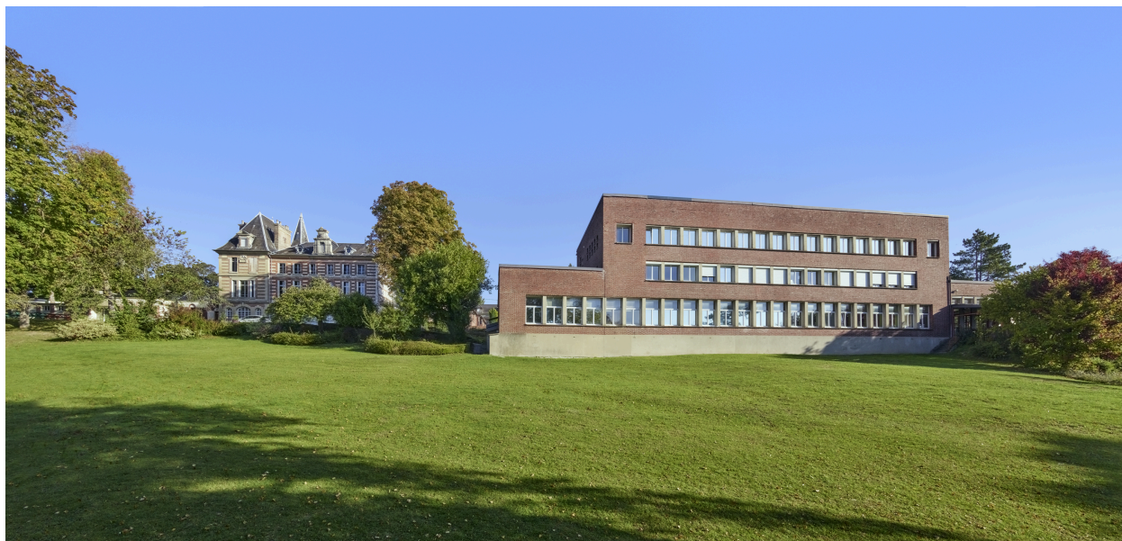
Vue d'ensemble de l'IME, depuis le parc.
