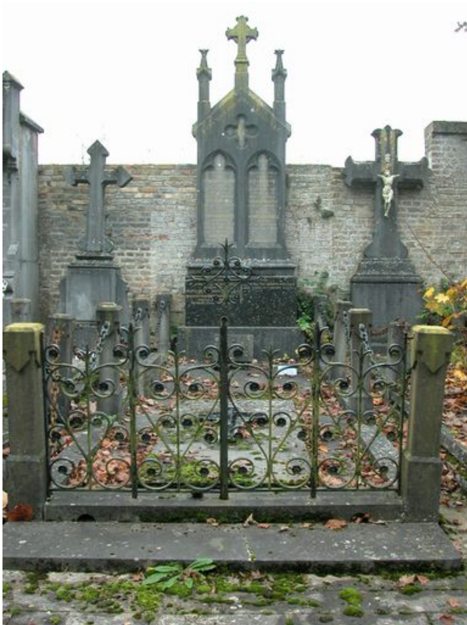
Vue générale, avec la grille.
