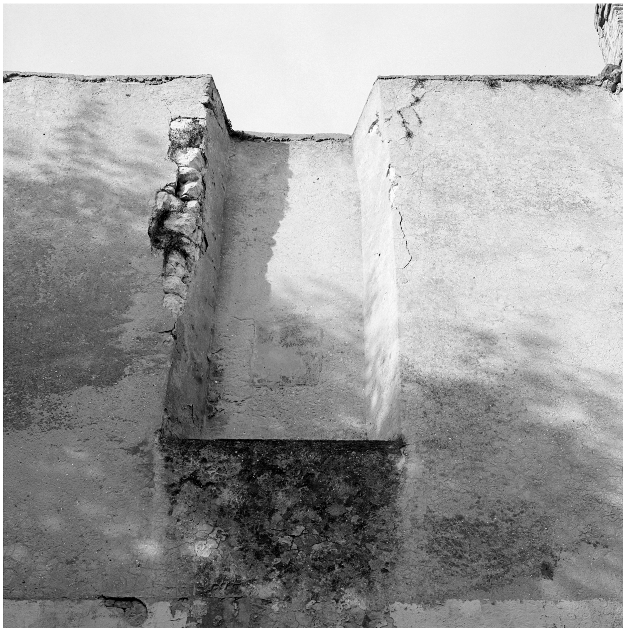
Bâtiment dans la cour 5 rue Henry, cour, mur nord, baie obturée.
