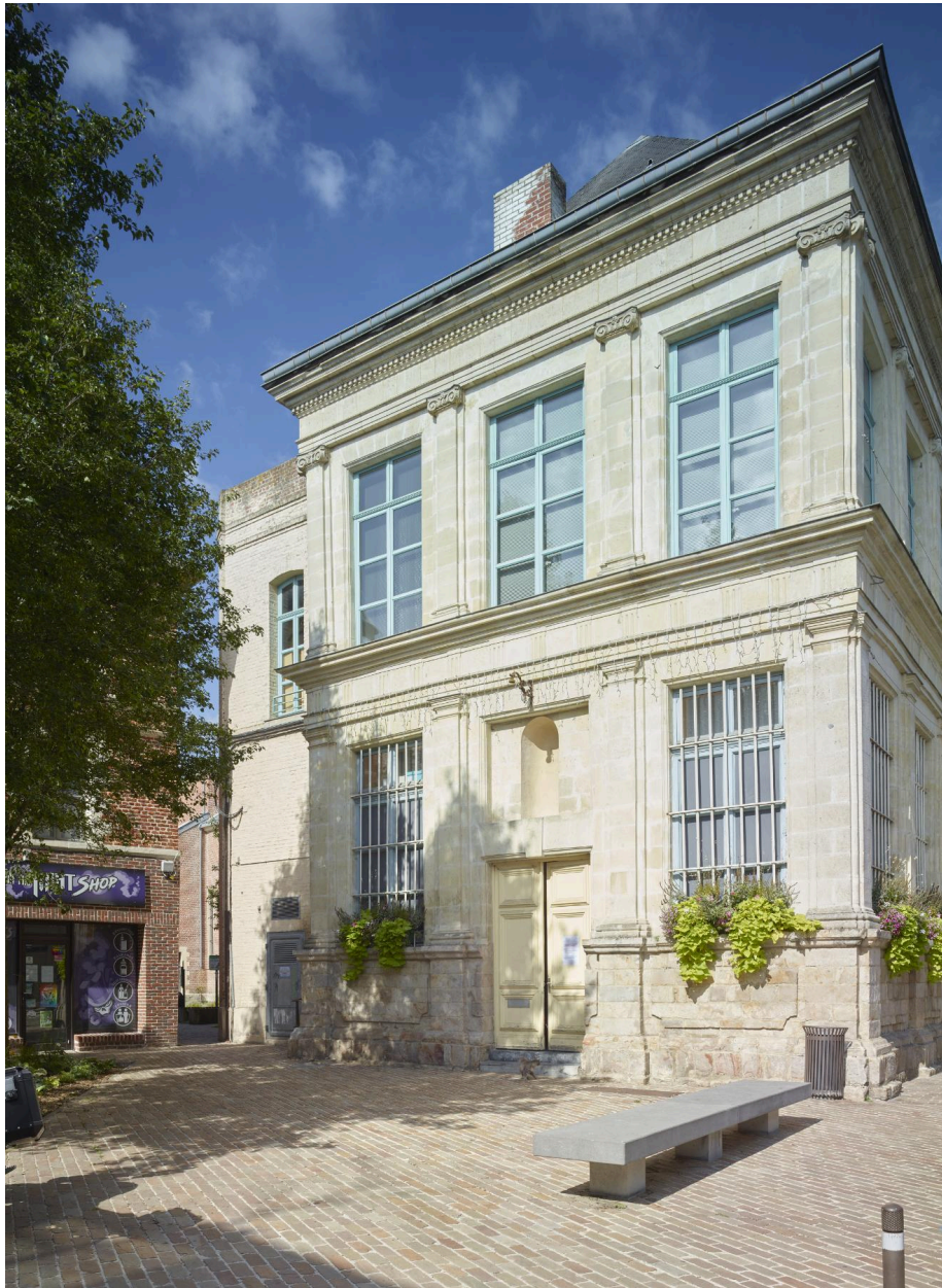
Façade latérale nord de l'Hôtel de ville depuis la place Saint-Michel.
