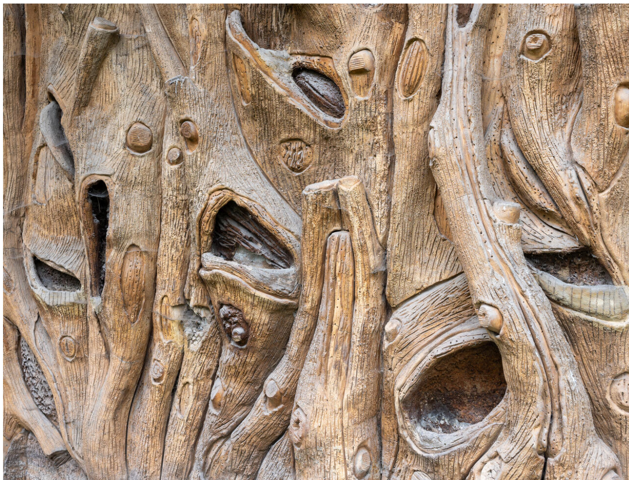
Appareil faux bois du mur du jardin d'hiver.
