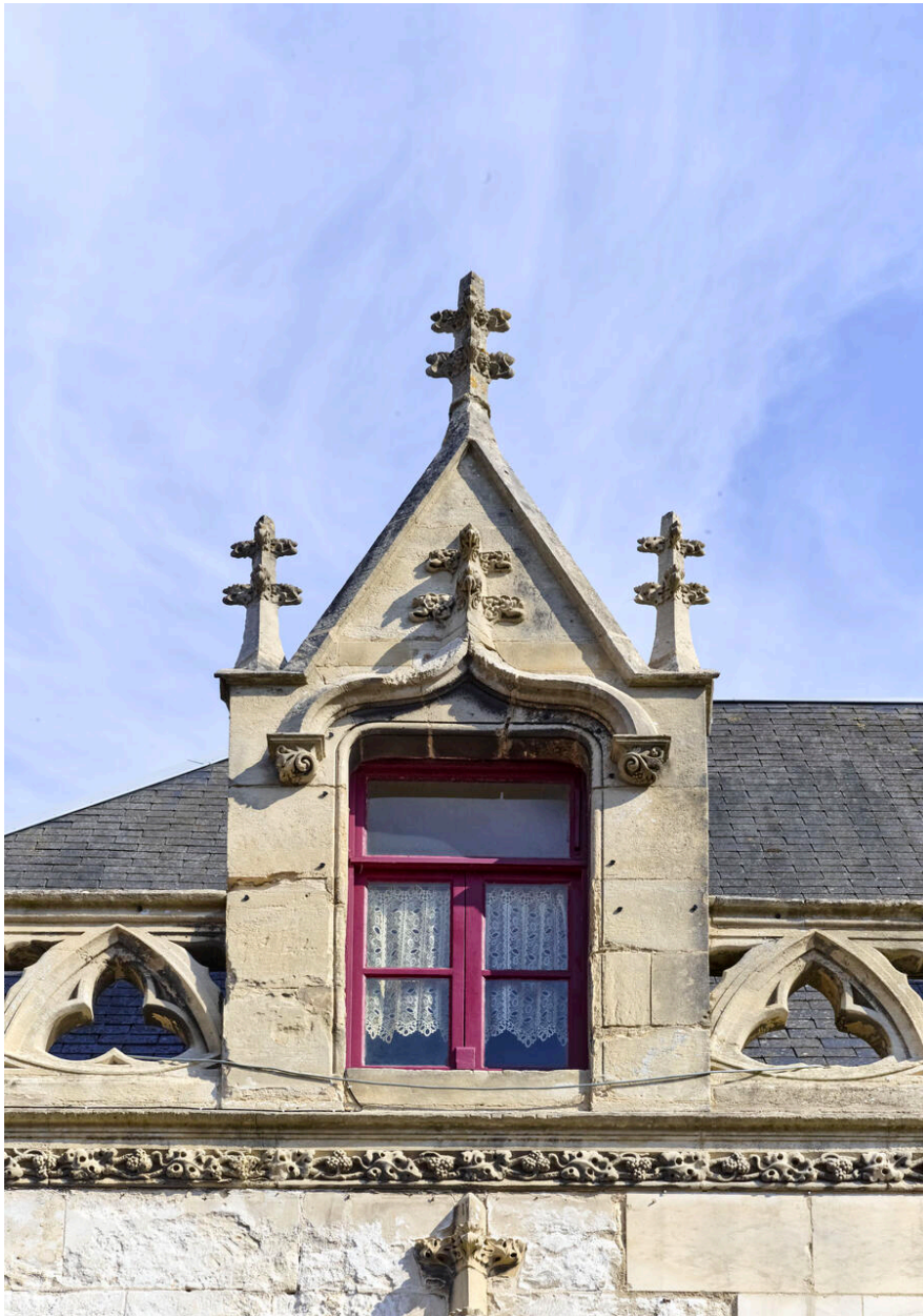
Détail d'une lucarne néo-gothique ornée d'un arc en accolade.
