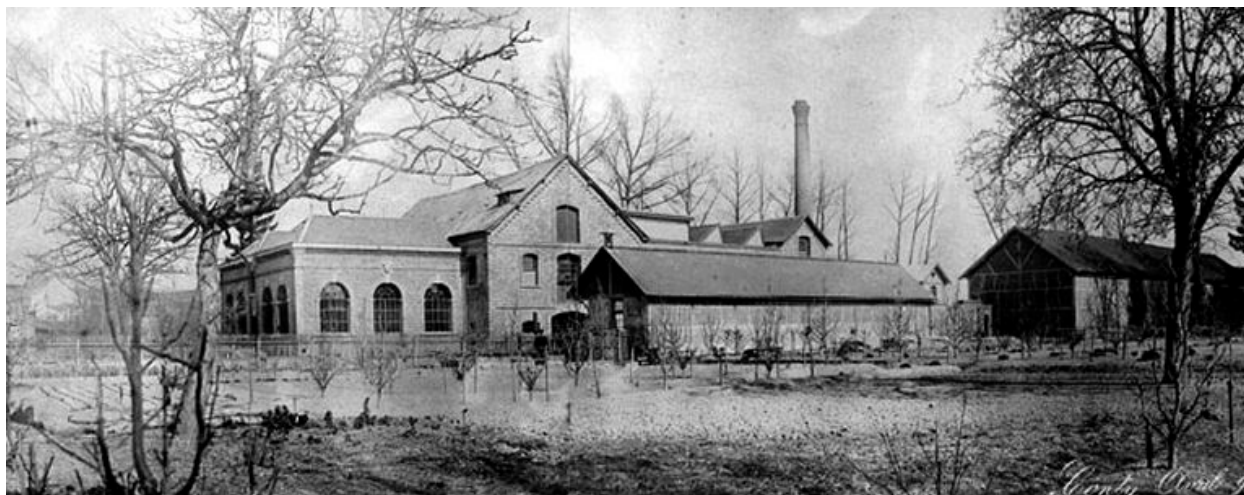
Vue de la salle des machines, photographie, vers 1890 (coll. part.).
